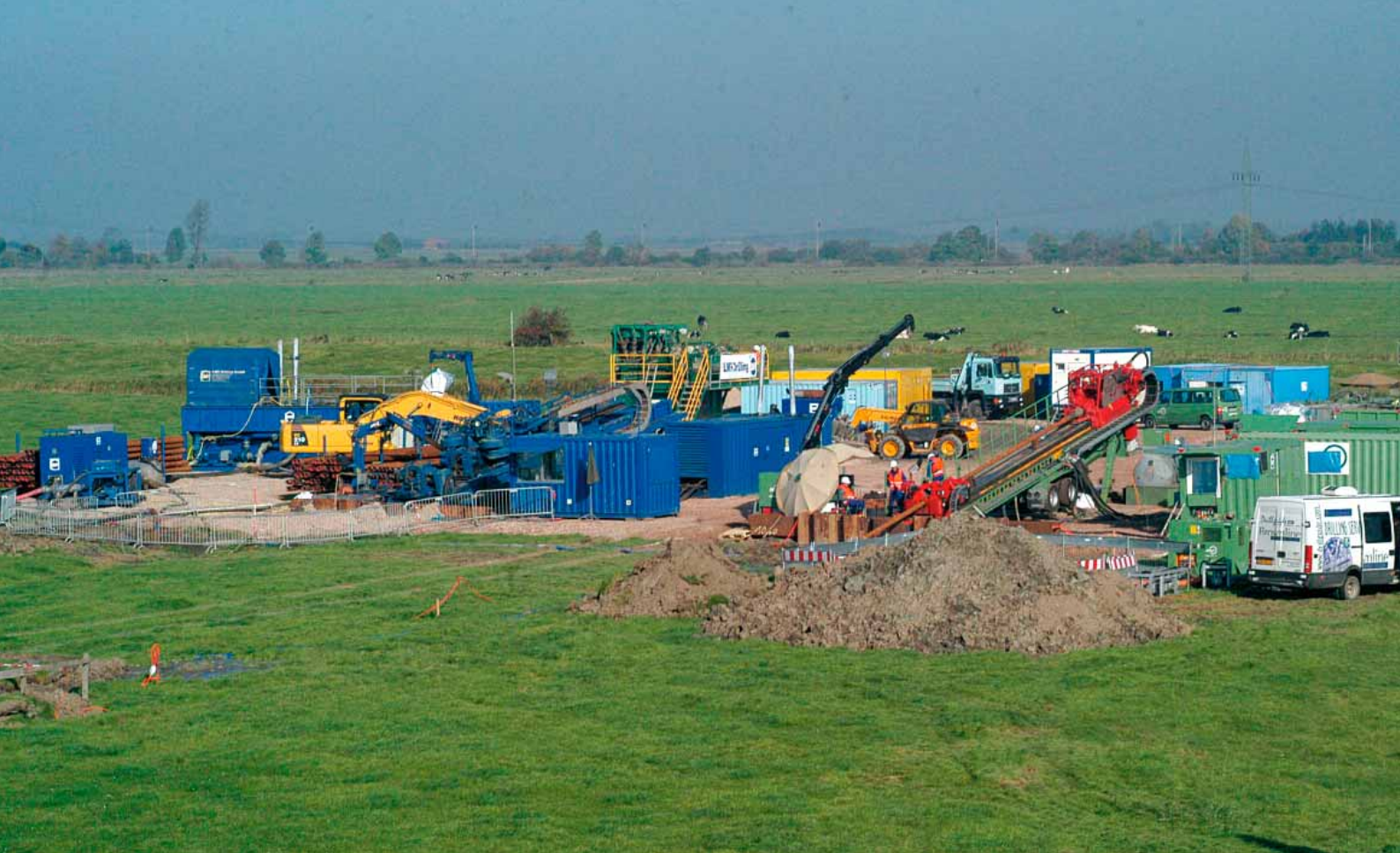
Zwei Bohranlagen mit 250 und 400 € Zugkraft arbeiten parallel.
