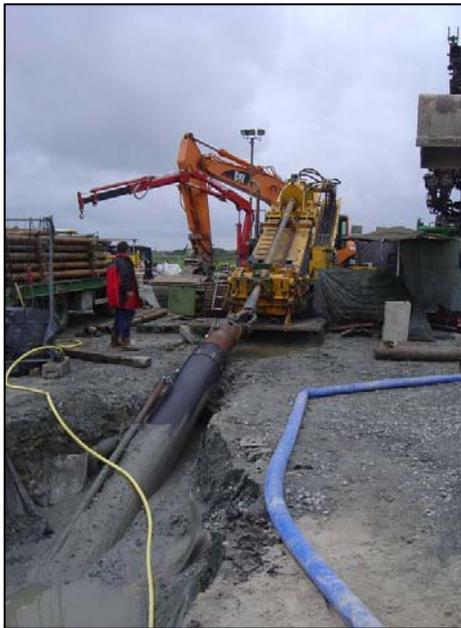
Bild 4: Eingezogenes Produktenrohr mit nebenliegendem Bohrgestänge
