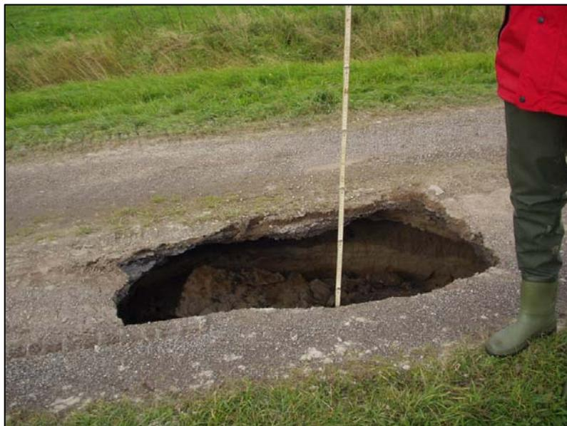
Bild 1: Bohrlocheinbruch in 12 m Tiefe
