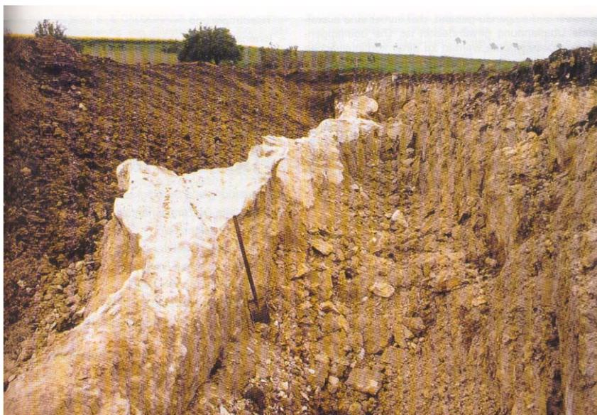
Bild 7: Ausgehärteter Ringraumdämmstoff
