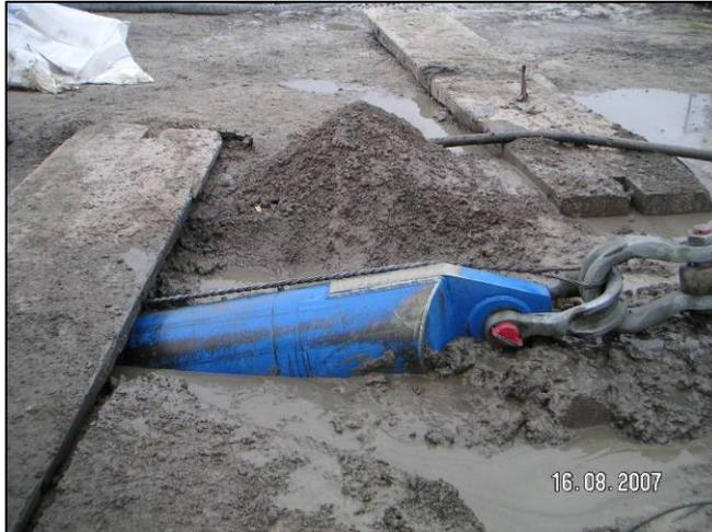
Bild 8: Befestigung des Gestänges mittels Stahlseil
